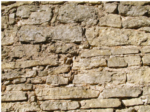
2 pav. Dolomito plokštės Noriūnų bokšto mūre
