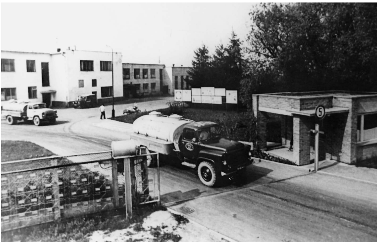
57 pav. Kupiškio sviesto gamykla po 1973 m. rekonstrukcijos. KEMA, invent. Nr. GEK 10195
